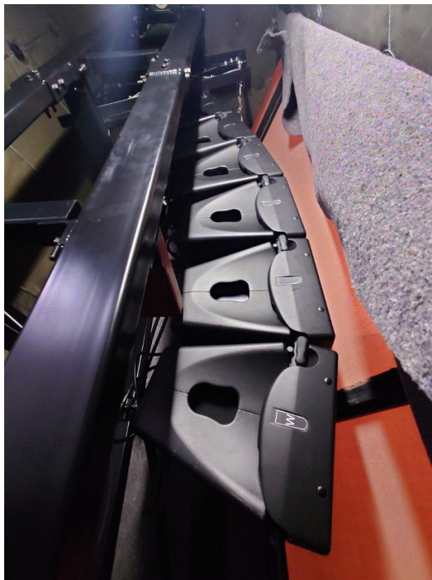
○メインスピーカーの設備更新 ポイント・ソース型からラインアレイ型へ
